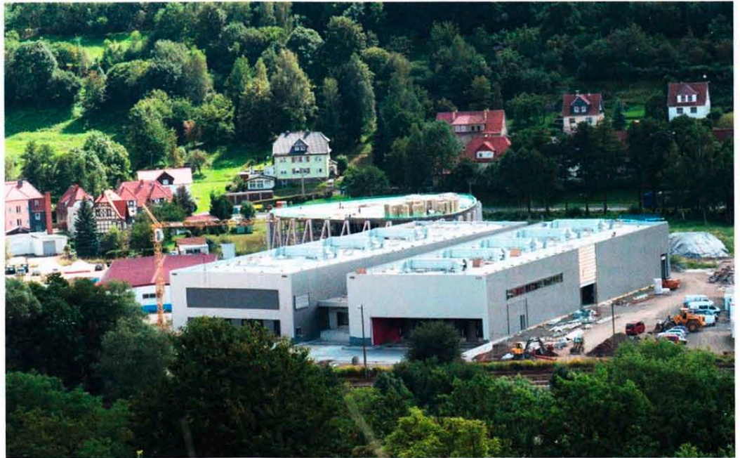
Zum Bauprojekt „Nougat-Welt“ gehören auch die beiden neuen Lagerhallen für Produkte und Verpackungen; zur Steuerung der Prozesse in den Lagern wird das datenfunktgestützte KDL-WOS eingesetzt
