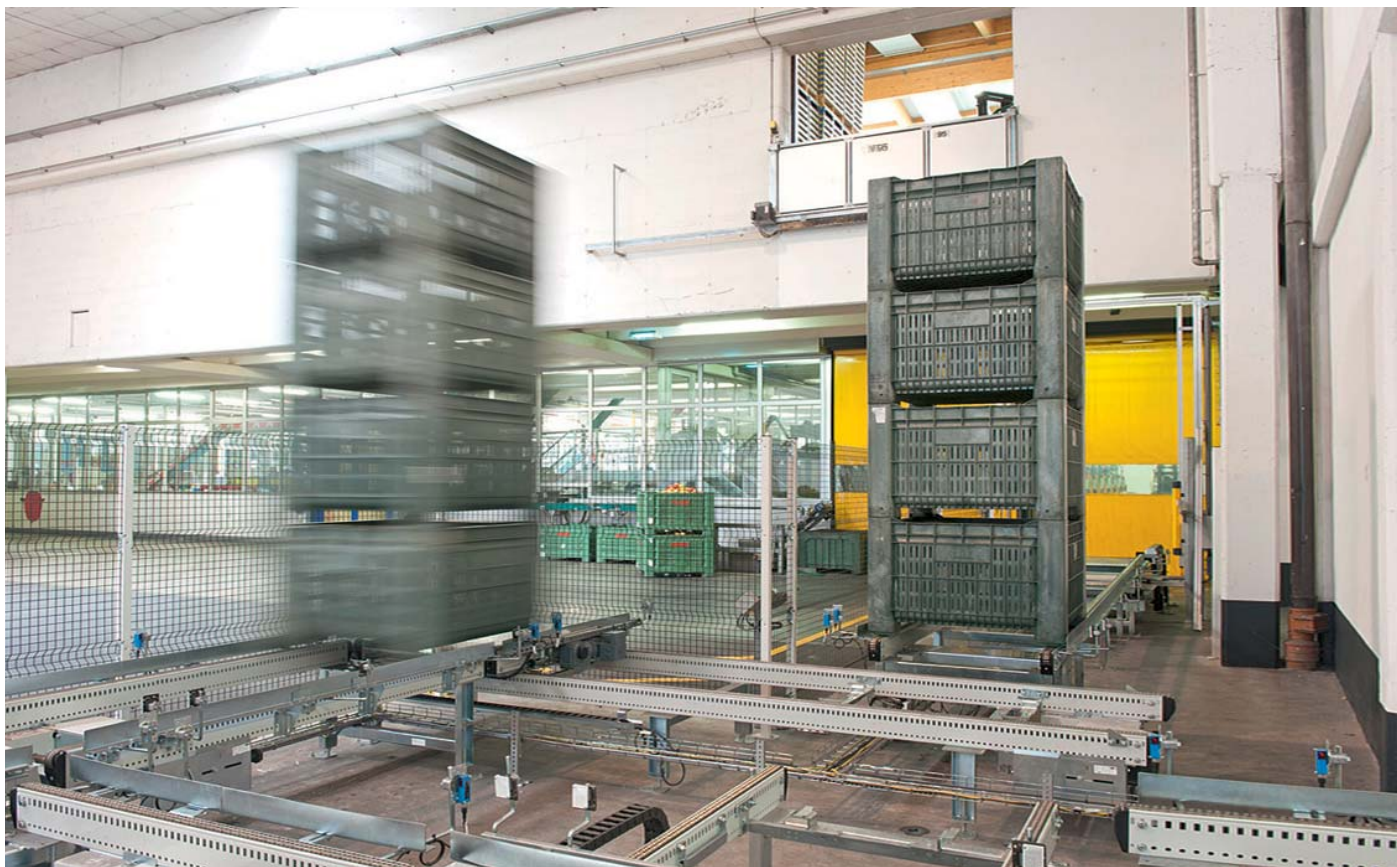
Die Vorzone Süd mit Anbindung an die Verpackung und zwei Doppel-Verschlebewagen
