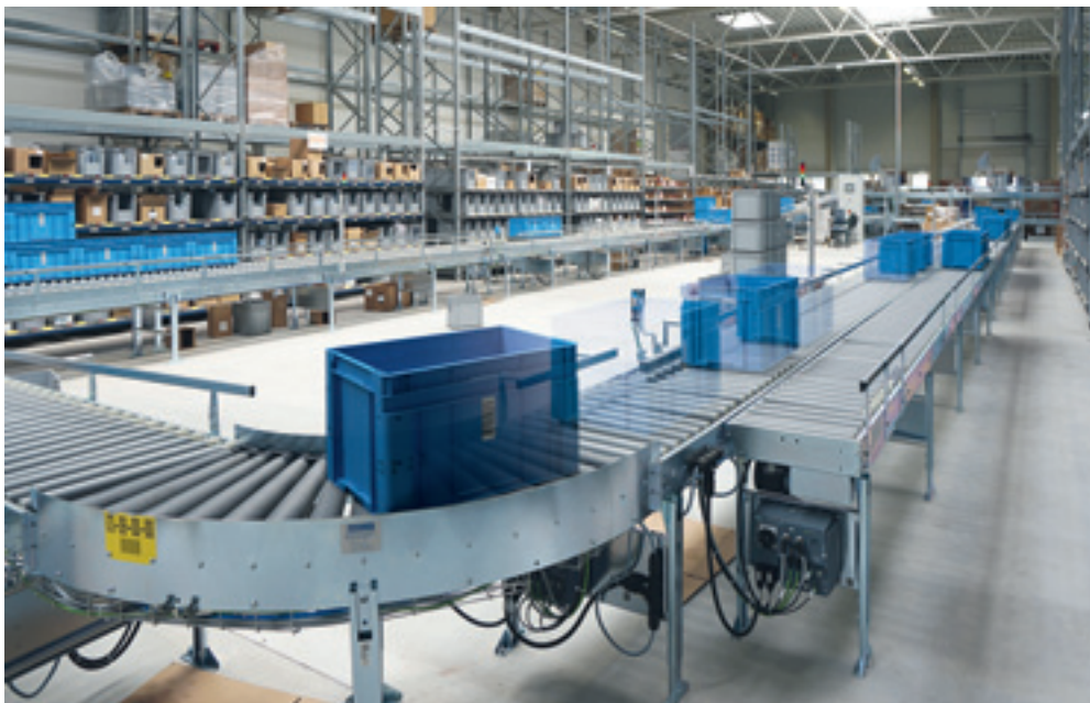
Das Herzstück: Ein Förderkreis für Kommissionierbehälter
